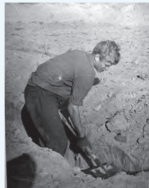
В стройотряде. Работы нулевого цикла. 1968 г.
