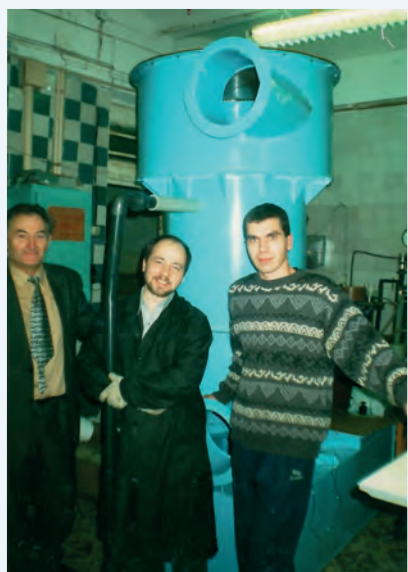
Монтаж промышленного абсорбера с пакетно-вихревой насадкой, изготовленного одним из учеников профессора В.Н. Блиничева — доцентом О.В. Чагиным перед внедрением на ювелирном заводе в поселке Красное-на-Волге
