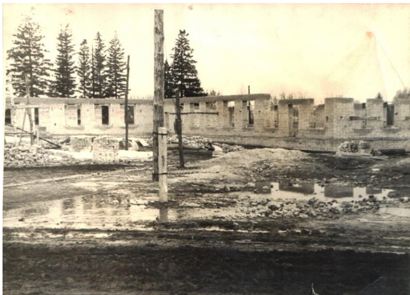
Строительство новой школы в с. Поддубровка. 1965 год
